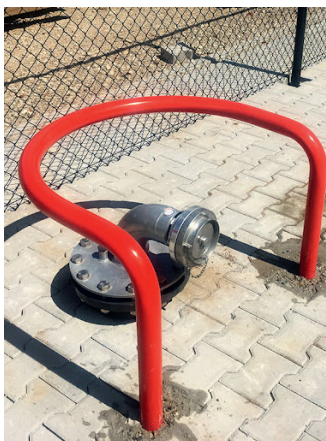
Figuur B 1.4: Voorbeeld uitvoering geboorde put
